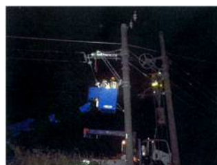
電車線支持物建替工事
