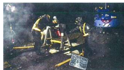
木マクラギ PC マクラギ化工事
