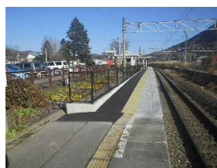
古間駅改良後
