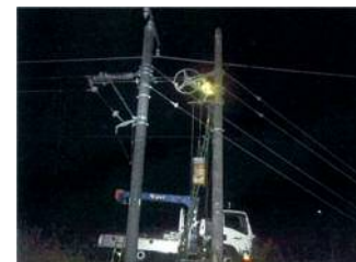
電車線支持物建替工事
